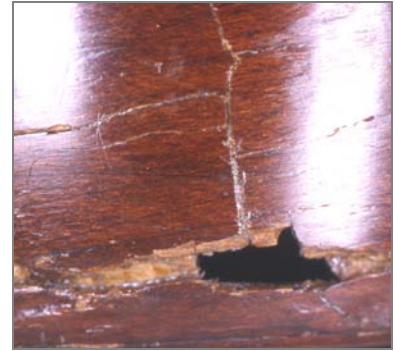
Abb. 17 Schaden am Zargen 8/596
